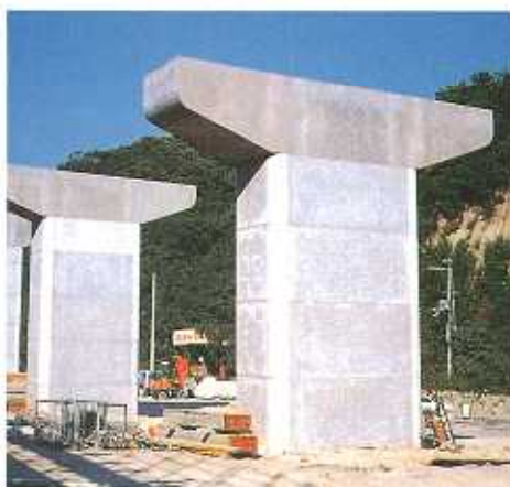
西神道路柏木谷高架橋への適用
